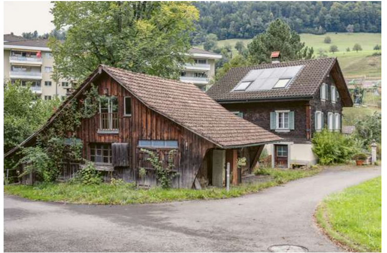
Baufällige Gebäude vor dem Abriss.
